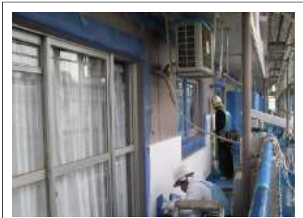
外断熱（ビーズ発泡ポリスチレン）改修施工風景
