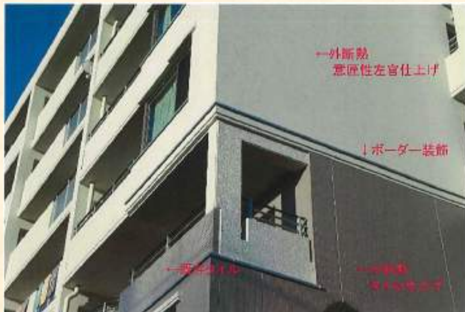
画像5 既存タイルと外断熱新設タイル 外断熱 意匠性左官仕上げ ポーター装飾
