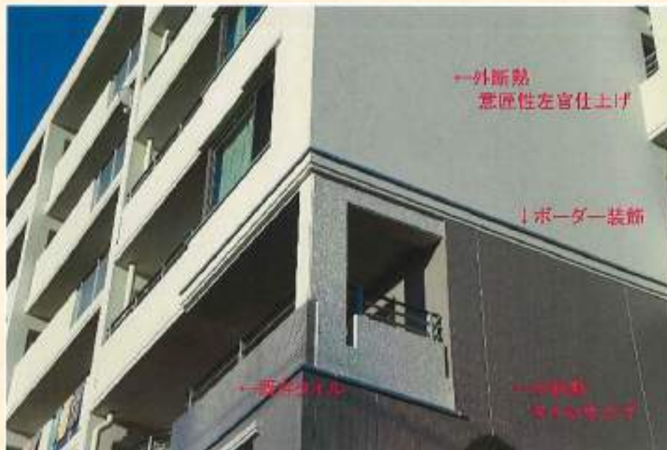
画像 5 既存タイルと外断熱新設タイル 外断熱 意匠性左官仕上げ ポーター装飾
